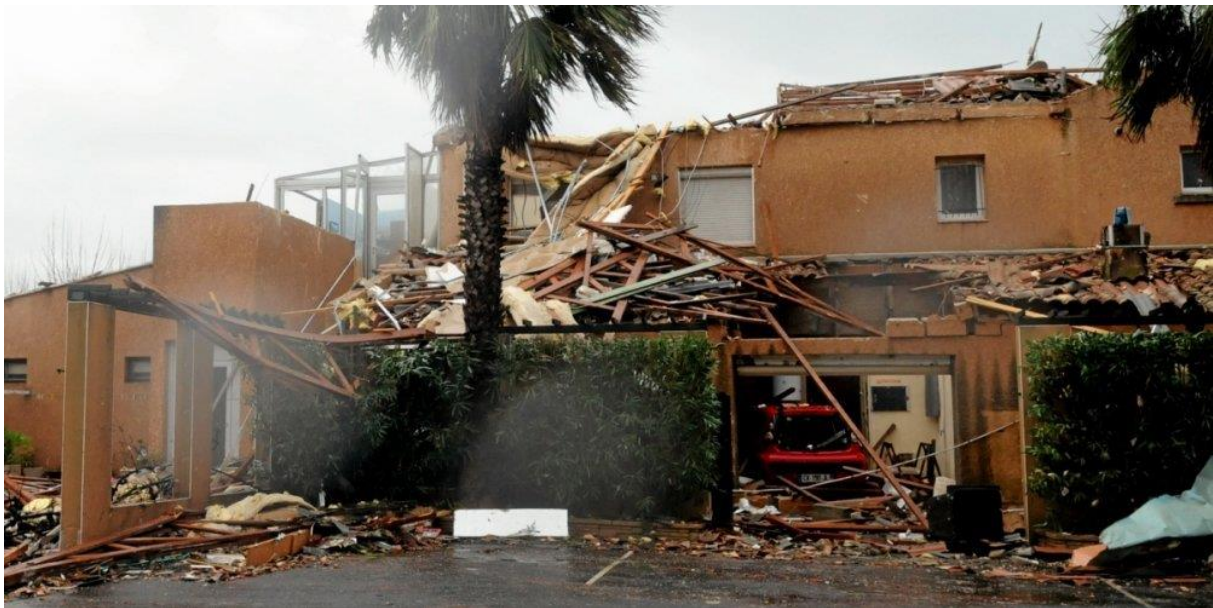
Dégâts suite à une tornade à Sérignan Plage (34) - Ven 28 nov 2014 - P. SALIBA pour Le Midi Libre
